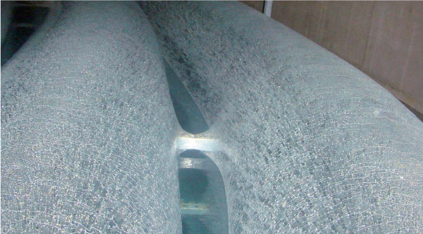
Eisbildung um den Wärmeübertrager im Eisspeicher
